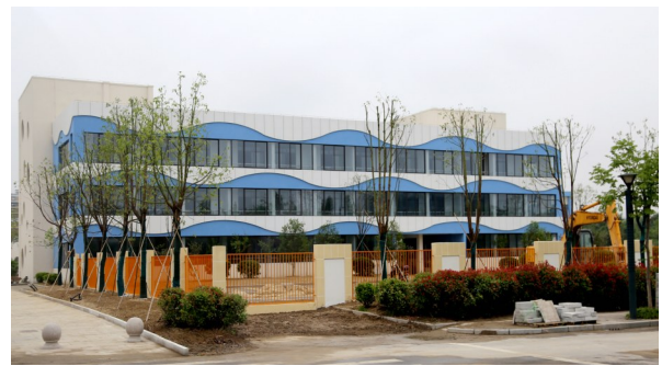
沿海实验幼儿园建筑面积约1万平方米,设置三轨18班,可容纳幼儿600人,将致力打造苏北一流的示范性幼儿园。目前幼儿园建设工程正在扫尾,拟于今年秋学期投入使用。 记者 戴海波 摄
