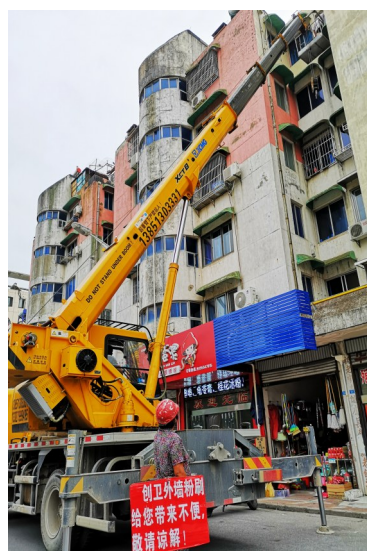
连日来,市住建局动用大吊车,在鼓楼西路为居住楼粉刷外墙。孙家录 摄
