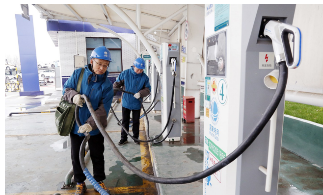
1月10日,富安供电所到沈海高速东台服务区,检查电动汽车充电控制设备,检测供电质量,助力春节绿色出行。 记者 唐雅 通讯员 孙永兴 摄
