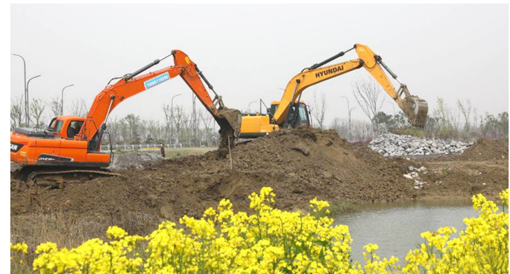
4月1日,市园林管理局抢抓有利天气,精心打造海陵南路绿化景观工程。据施工负责人介绍,他们正打足工时,开挖生态湖,为大美东台再添一高品质景观长廊。邹洪喜 刘宝余 摄
