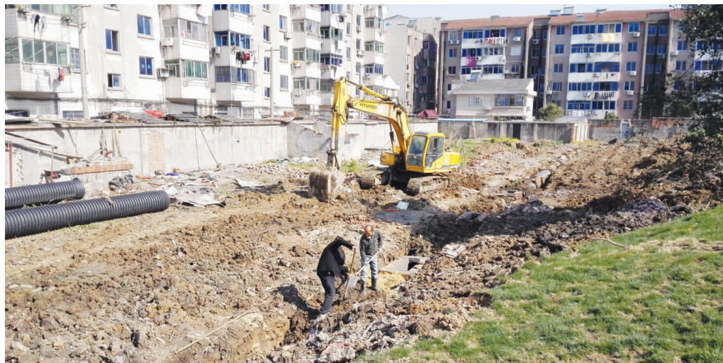
违建围墙已拆除,施工人员进行雨水管道施工
