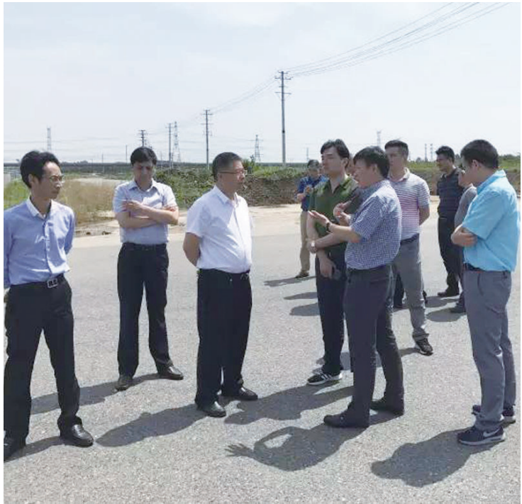
开发区领导在项目建设现场办公
