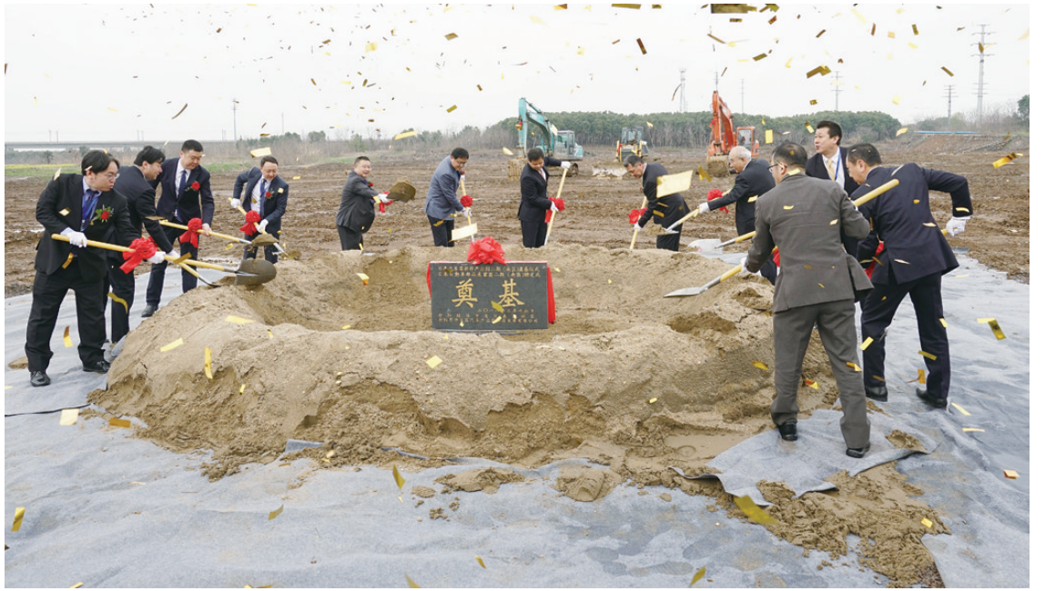
▲市领导为日产业园二期(南区)培土奠基。 记者 蒋玉 通讯员 开轩 摄
