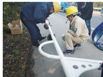
图为路灯所工作人员正在安装路灯。记者 李潇 摄
