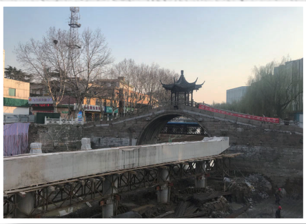
改造中的公路与通泰桥
