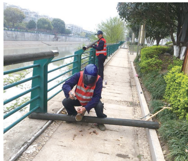
连日来，市城管局河道管理所对城区河道的护栏进行全面检查和维修。图为河道人员在对香草河桥附近的木质护栏进行维修。（记者 王国禹 通讯员 刘立霞 摄）
