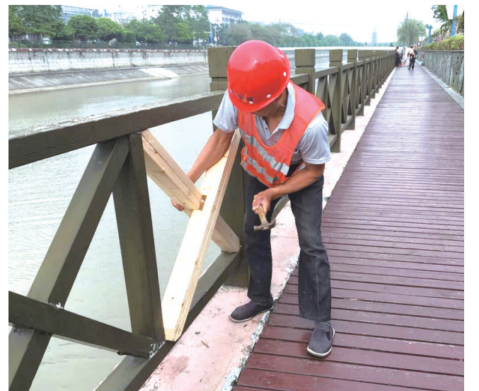
最近,有热心市民发现,香草河华南桥东南侧有一处河道护栏因年久失修已经严重腐蚀、松动,存在很大安全隐患。为及时消除安全隐患,市城管局河道管理所立即对此处河道护栏进行了修复和加固。(记者 王国禹 通讯员 刘立霞 摄)
