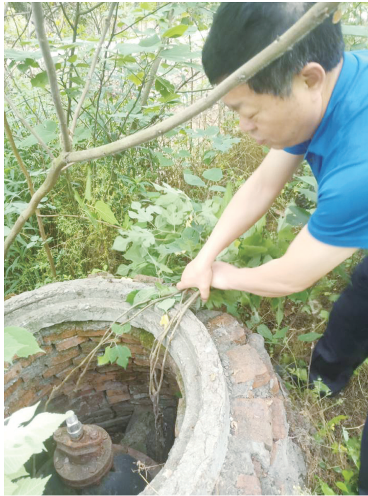
徐双春在查看村里的自来水管网时, 清除杂树。 记者 鹏翔 摄
