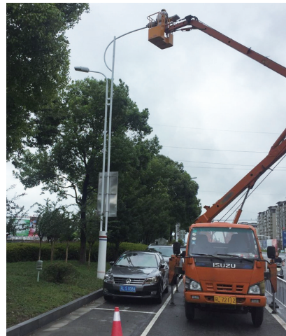
受超强台风“利奇马”影响,我市部分地区遭暴雨侵袭,导致部分路灯控制箱进水电线烧坏。11日开始,城管局路灯所全力开展抢修工作,及时处理台风过后带来的安全隐患。
