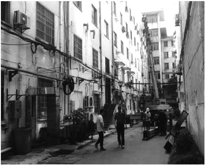
图为旧烟囱拆除现场。记者 王国禹 摄
