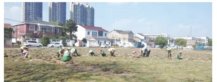
园林工人冒高温铺设地坪。记者 鹏翔 摄
