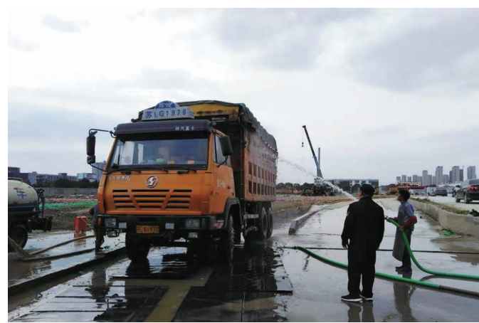
为给市民营造一个更加舒适干净的生活环境,近日,城管部门加大了全市范围内的扬尘治理整治工作,多措并举管控扬尘污染。图为执法人员在督促工地施工方清洗车辆,防止车辆带土上路。(记者 王国禹 通讯员 王芳 摄)
