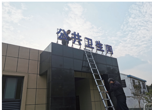
连日来,市城管局环卫处组织人员,对公厕内各类设施进行全面维修、擦洗,为市民提供良好的如厕环境。
