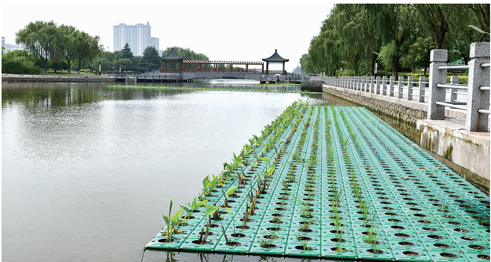
近日，细心的市民会发现，在县城周口水面上栽植了许多翠绿的植物。据了解，这是县住建部门为了改善水环境，在水面上建设的生态浮岛。据了解，生态浮岛是用可漂浮材料为基质，将高等水生植物栽植到水域中，通过植物的根系吸收或吸附作用，对河水有机污染物起到很好的促进降解作用，达到修复和重建水生态系统、净化河道的目的。 (尤子龙 摄)
