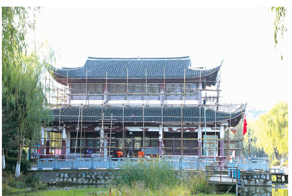
12月2日,工人师傅对县海西公园内的将军阁进行维护保养。为确保冬季公共设施安全,全面保障人民群众生命财产安全,县综合行政执法局对辖区公共设施进行全面的安全生产检查,针对存在的安全隐患进行部分拆除、加固或保养,确保各项设施安全高效服务于民。(秦宁建 摄)
