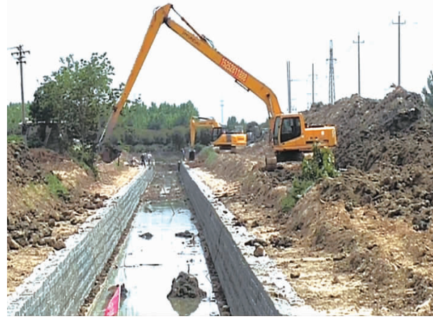
我县水环境治理工程于3月底开工,目前已疏浚河道2500米,完成建筑物基坑开挖,计划5月底完成水下部分,8月份全部完成。惠庄中沟2300米已疏浚2100米,惠庄闸站完成底板和洞身浇筑;中心大沟840米已疏浚400米,自嵌式挡墙1600米完成基础800米、墙身砌筑300米。项目完成后,将提高城南片区的防洪排涝能力。(于子龙 摄)
