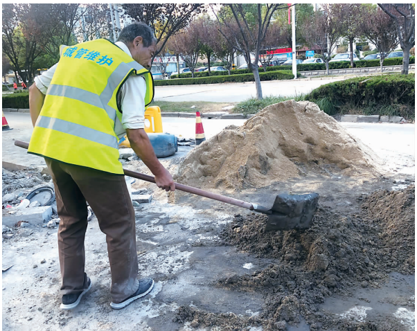
为进一步完善市区基础设施建设，为市民提供良好的出行环境，县综合行政执法局城市维护队对城区内松动、破损人行道板、沥青坑槽等问题开展了专项维修。
