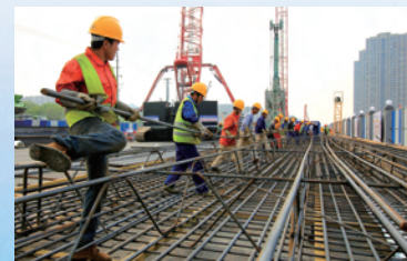
1号线永兴大道站施工。
