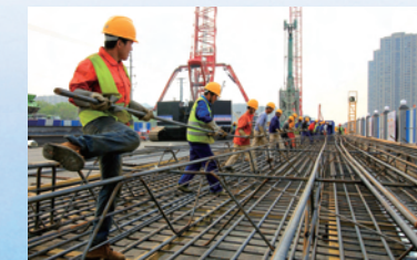
1号线永兴大道施工。
