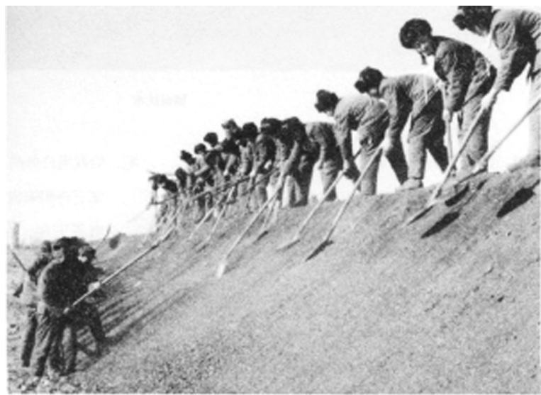
修筑通往导弹试验基地的铁路路基
