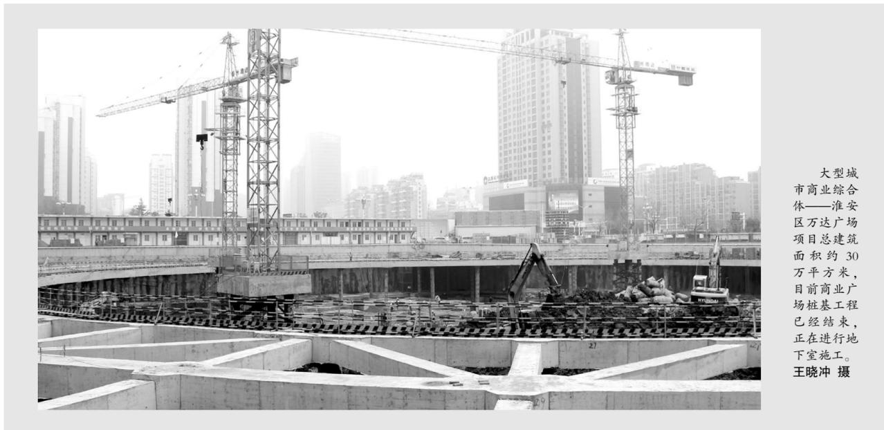
大型城市商业综合体——淮安万达广场项目总建筑面积约30万平方米，目前商业广场桩基工程已经结束，正在进行地下室施工。王晚冲 摄
