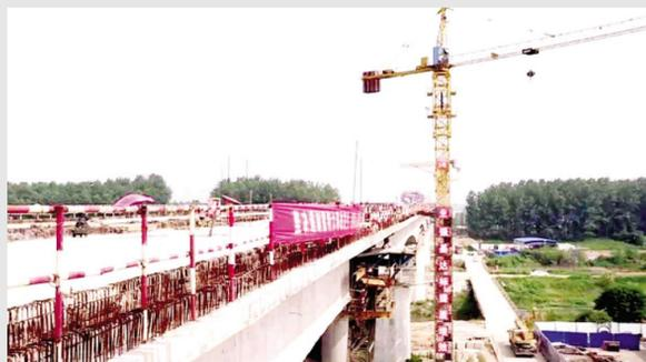
6月8日下午，连淮扬镇铁路跨苏北灌溉总渠特大桥最后一处连续梁完成浇筑合龙，标志着连淮扬镇铁路淮安段突破最后一个技术难点，完成境内全部连续梁的施工建设。据中铁四局连淮扬镇铁路项目经理部办公室主任姬贺介绍，下一步箱梁预制架设工作将继续向南推进，在7月中旬完成徐宿淮盐铁路和连淮扬镇铁路的双线铺架工作，8月份进入铺轨施工，9月份开始电气化施工。
