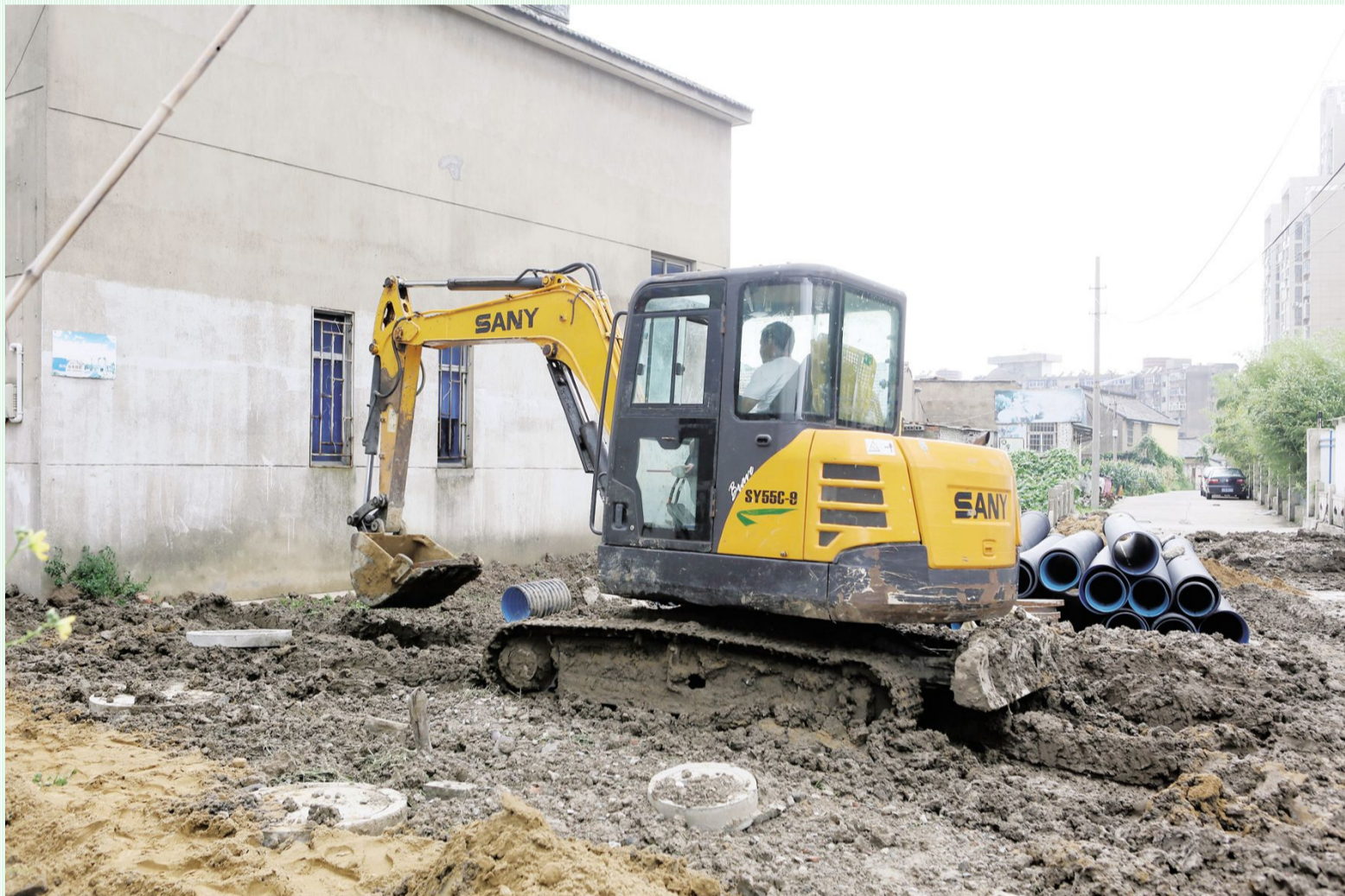
城区10条后街背巷整治改造自5月份启动以来，区市政公司按照总体部署和施工规范要求，紧盯时间节点，全力以赴抢抓工程进度。目前，桥南小区东西路、五七农场巷、老跃进路已竣工，衡洼中街、湛神寺巷等改造工程正在按序时推进中。图为韩桥巷改造场景。李峰摄
