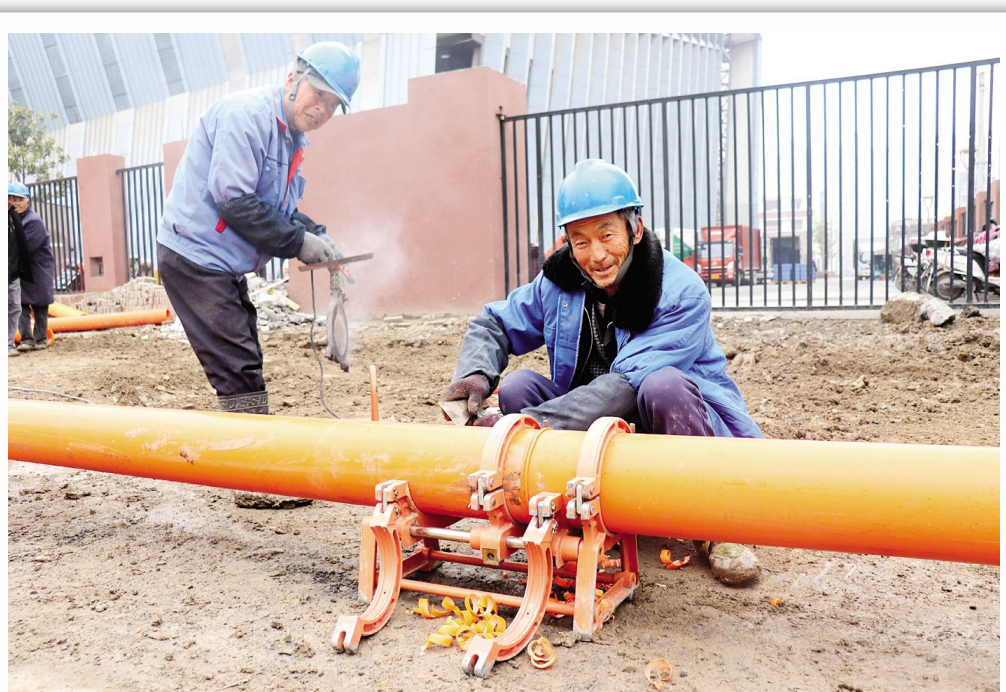
为服务广大市民,保障电力供应,区供电部门从山阳街道至新城市广场新铺设管道,全长约5公里。图为翔宇大道管道铺设现场。
