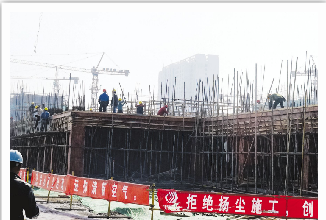
周恩来红军中学西校区新建工程位于经五路东侧,承恩大道南侧,经六路西侧,规划一路北侧。该项目总投资约1.34亿元,占地面积约71.38亩,规划校舍总建筑面积51732平方米,可容纳学生2400人。目前正在进行教学楼、宿舍楼一二三层主体结构施工和风雨操场筏板基础浇筑、地下室模板排架,预计今年秋季开学可投入使用。
