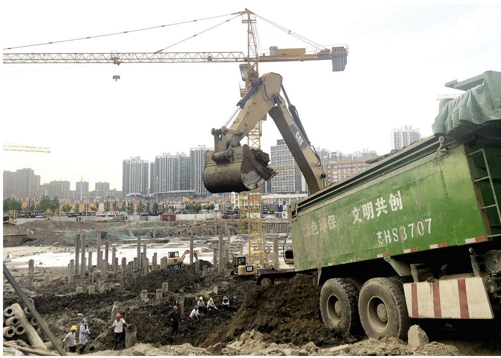
萧湖人家三期安置小区位于国际商城经二路东侧，商城路南侧。该工程建筑面积约8.6万平方米，总计安置户数642户，计划2021年10月2日完工。目前工程已完成桩基施工、边坡支护，正在进行垫层、主楼及地库防水卷材施工。图为项目施工现场。王丹摄
