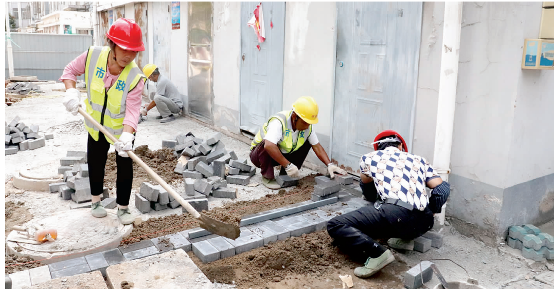
富士花苑老旧小区改造工程正在如火如荼地进行着，目前4323米雨污管网改造已完工，面砖铺设1600平方米，植草砖铺设1800平方米，围墙改造490米。图为面砖铺设施工现场。王丹 郇玉乔 摄
