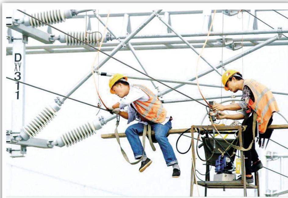
日前,工人在高铁淮安站建设工地安装输电线路。淮安站是宁淮城际铁路、京沪高铁二线、连淮扬镇铁路、徐宿淮盐铁路、淮蚌铁路等多条客运铁路的重要枢纽站点,预计今年12月15日建成投入使用。 周长国 摄
