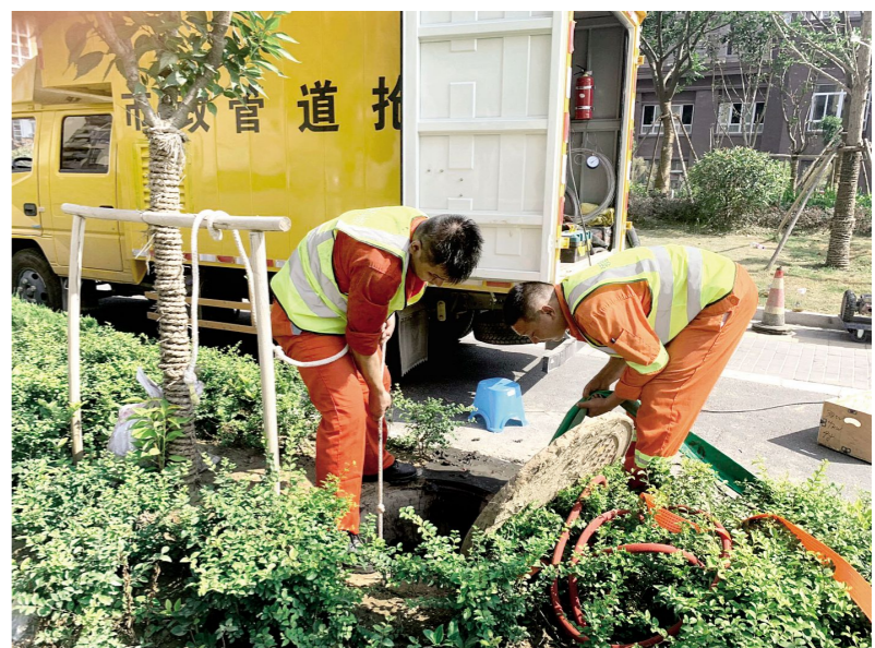
近日,区市政公司组织开展城区主要道路排水管网整修工作,施工人员对有堵塞、淤积情况的排水口、检查井及管道逐一进行清理疏通。图为镇海路施工现场。
