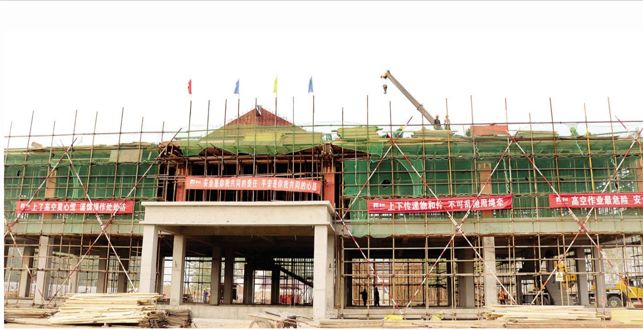
华润99MW风电项目由华润电力新能源投资有限公司投资建设,计划总投资10亿元人民币,项目选址车桥镇和施河镇,占地52亩,布局45台单机容量为2.2MW风力发电机组,轮毂高度140米,预计年发电量2亿度。目前,升压站二层封顶,施河镇受河村风电站点施工中。 严曼曼摄
