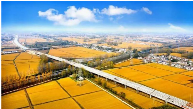
跨京沪高速大桥
