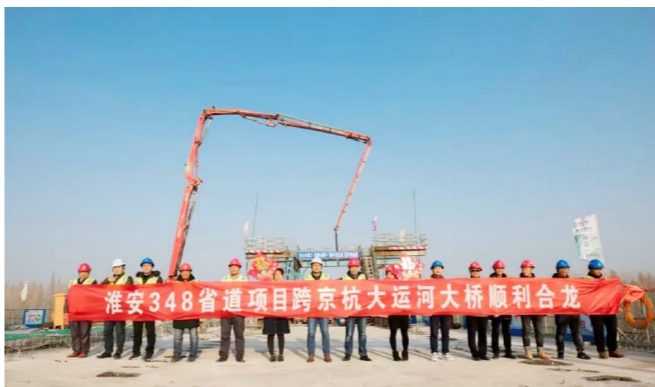
跨京杭大运河特大桥合龙
