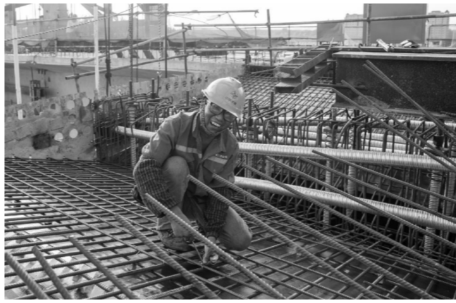
钢筋安装工人
