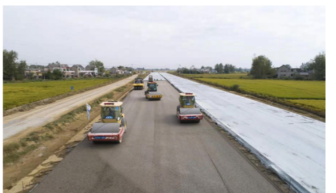
348省道基层水稳碎石施工现场
