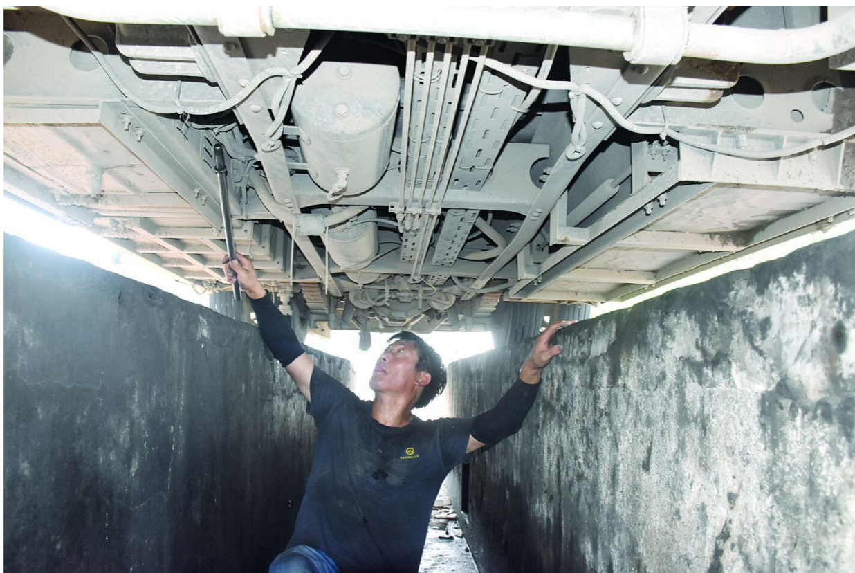
连日来,持续高温。区客运运输总公司组织青年车修突击队三班轮流转,全天候奋战在热浪滚滚的地沟中,切实保障公司520辆运营车辆安全运行,不误班次、不误点。图为突击队员在地沟中检修公交车的底盘部件。 章荣华 摄
