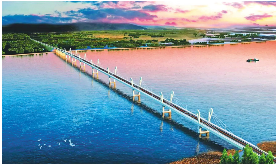
建单位和监理双方的严格测试,综合涂层附着力、涂膜厚度等各项指标均优于合同标准,全面通过审核。
