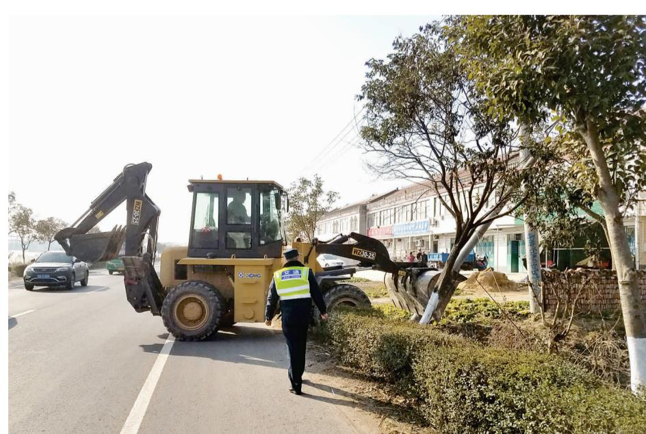
日前，区路政大队路政人员巡查至236省道152K+580M处时发现一根电线杆呈60度倾斜偏向路面。该站路政人员下车勘察后发现，电线杆底部已经严重损坏，电线杆被两根绷紧的钢丝绳拉着才没有倒下。这种情况非常危险，一旦钢丝绳松动，电线杆将倒向路面，很可能引发严重的交通安全事故。该站路政人员立即对现场进行交通管制，并调来一辆铲车，对破损的电线进行清理，保障了道路通行安全。图为破损电线杆清理现场。
