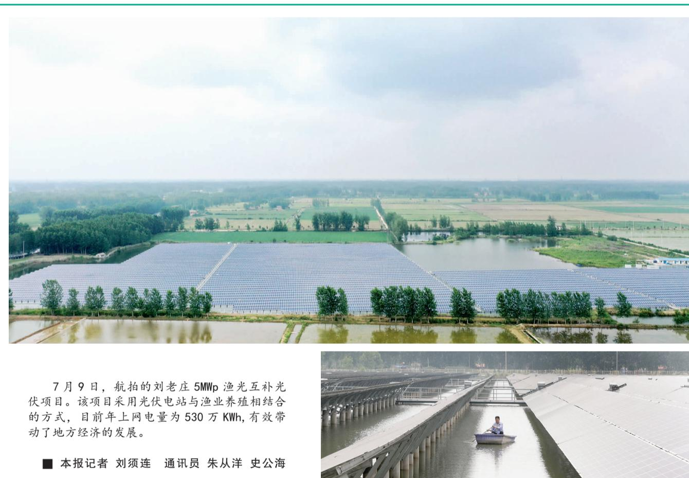
7月9日，航拍的刘老庄5MWp渔光互补光伏项目。该项目采用光伏电站与渔业养殖相结合的方式，目前年上网电量为530万KWh，有效带动了地方经济的发展。
