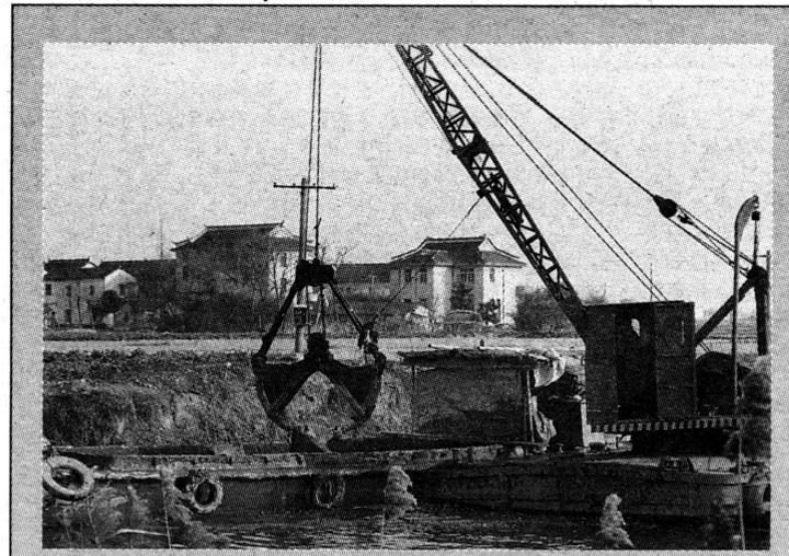
按照“安全、资源、环境”协调发展原则,我区高起点、高标准地开展了冬春水利建设。目前,全区已完成水利土方551万立方米,其中疏浚整治河道193条段,271公里,429万立方米;已超额完成市下达的计划任务;清理外三沟1731公里,63.6万平方米,平整地3025亩,48.8万立方米,其它土方10.4万立方米。图为挖泥船正在疏浚河道。(朱云明摄并文)
