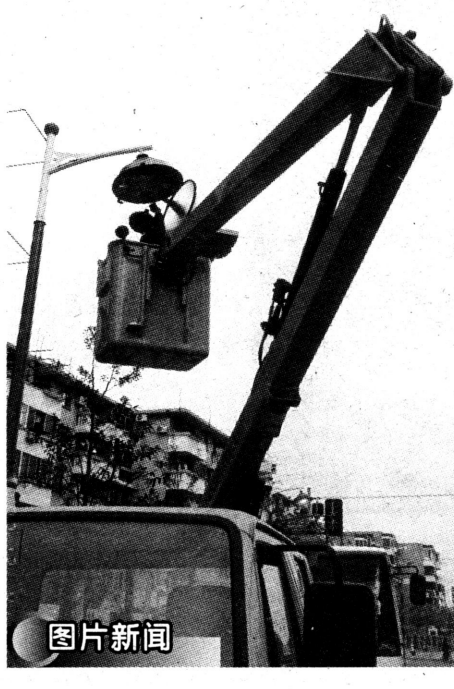
日前,改建的温宿路两旁开始安装造型别致、颜色橙红、射线妩媚的路灯,装扮了嘉定城内又一个亮点。图为供电部门工人正在工作。 ■张文国 摄影报道
