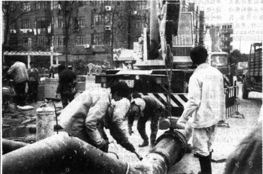
图为工人们在安装输水管道。(摄影:沈文娟)
