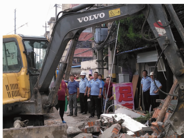
安全高效开展拆违工作
