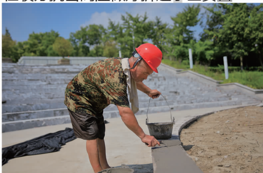
龙川广场升级改造工程施工现场
