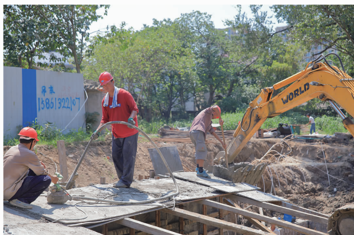
张纲河整治现场
