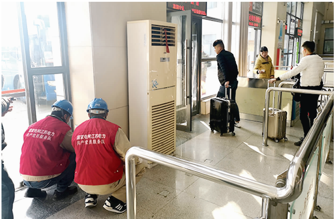
13日上午，县供电公司黎城供电所组织6名“共产党员服务队”队员来到县汽车客运站，对用电设备进行全面复检，确保各项设备用电安全，让返程旅客走了、走好。吕殿才 摄
