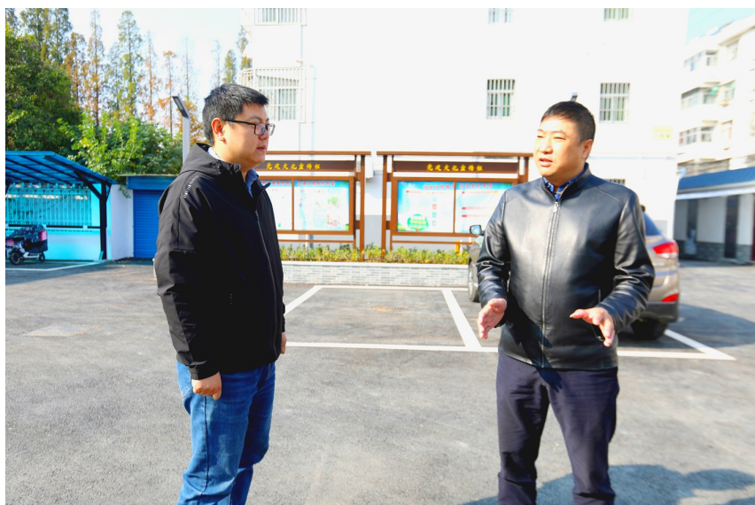
经理柏广兵（右）在县委党校家属区改造工程现场安排工作
