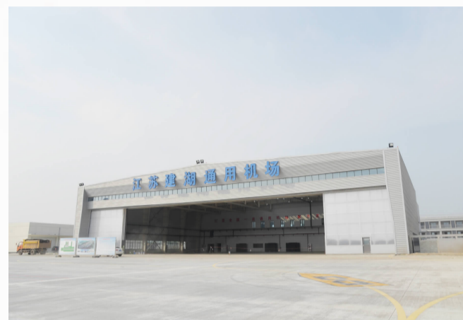
图为通用机场项目建设现场。
