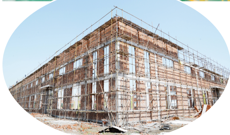
图为贝肯新能源项目二期工程建设现场。
