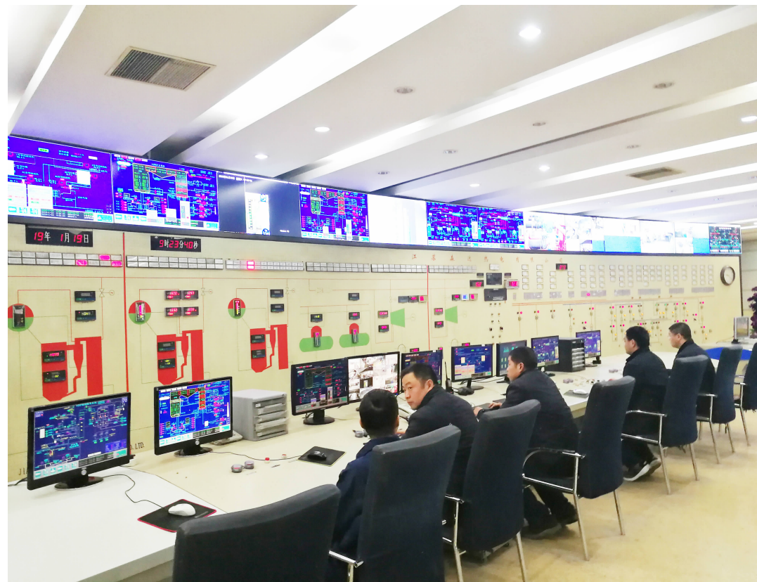
“去年,公司共投入1.5亿元进行二期生物质替代项目改造,其中2号燃煤锅炉12月底完成改造并投入运行,1号燃煤锅炉将在2019年7月份前改造到位并投入运行。”日前,在江苏森达热电集团有限公司集控室内,公司相关负责人告诉记者。据悉,近年来,该公司坚持绿色发展理念,大力实施生物质替代项目改造,致力于居民生产生活提供清洁优质能源。图为江苏森达热电集团有限公司集控室。杨程程摄
