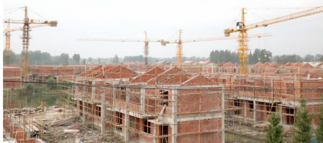
连日来,高作镇组织施工人员加紧建设“光明人家”集中居住点。该居住点建筑总面积达22199.2平方米,总户数达378户,将建有服务中心、健身广场、竹林书院、怡静湖、草编工坊等功能设施。目前,该居住点在建一期工程新建房屋42幢,共计150户。“光明人家”集中居住点建成后,将大力改善该镇农民住房条件。图为“光明人家”集中居住点建设现场。 肖元元 陆建军摄
