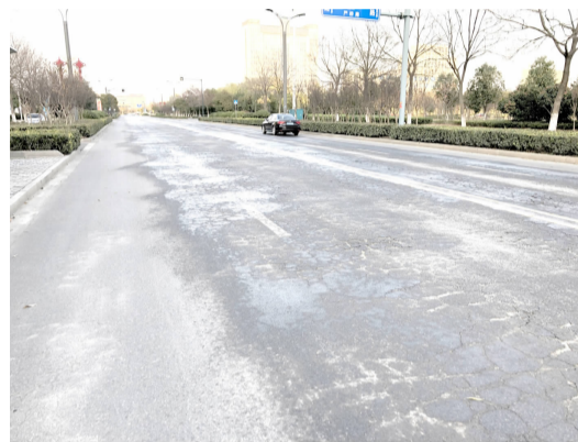
图为秀夫路(登达新天地东门口)路面破损。
