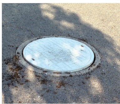
窨井盖更换完成。
