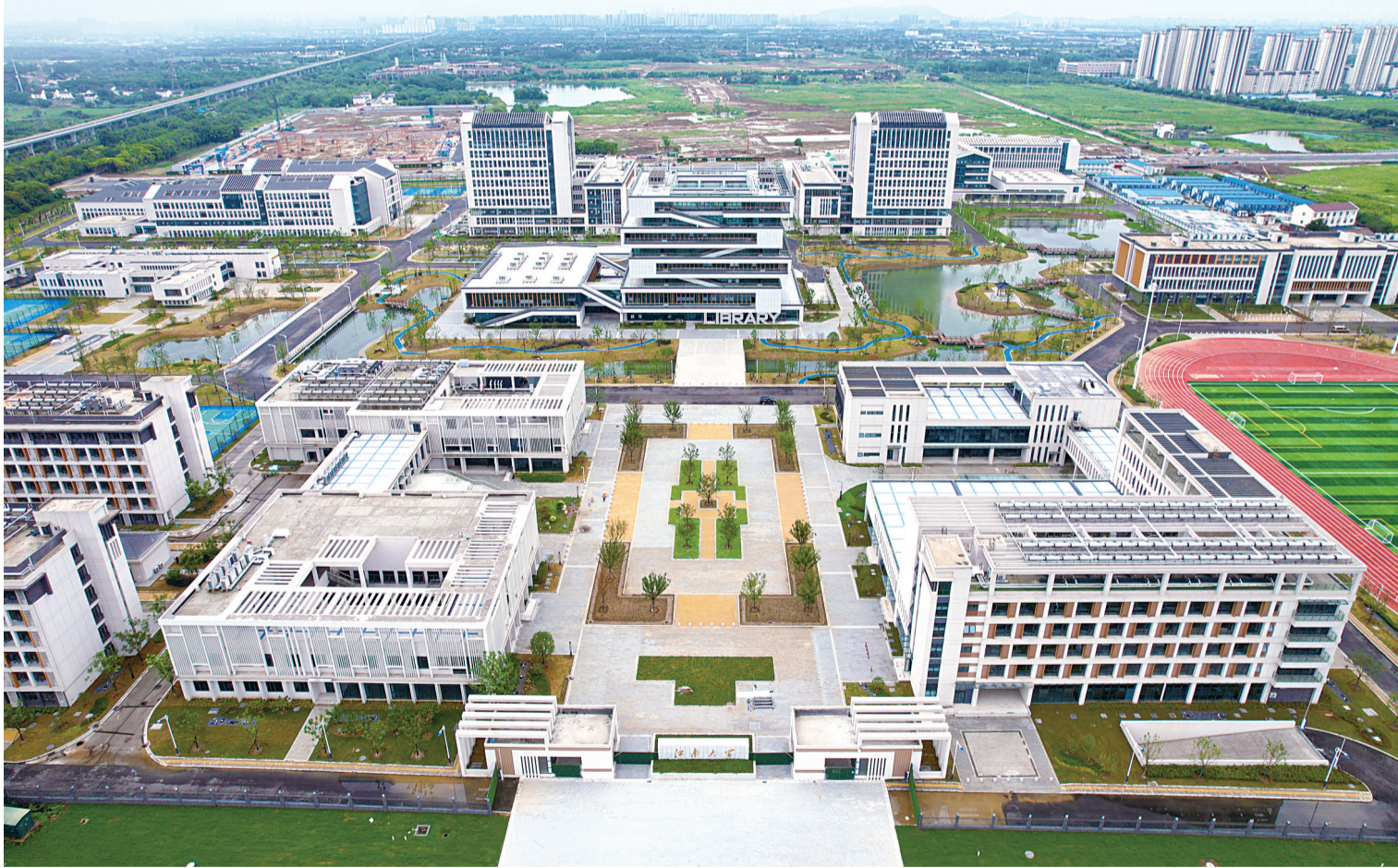
全新闻亮相。近日,江南大学(江阴校区)已顺利通过竣工验收备案,实验楼、教学楼、图书馆、体育馆等建筑已
